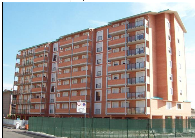
Figura 4.7.3/6 : L'edificio residenziale pluripiano confinante a nord ovest con l'area di cantiere
