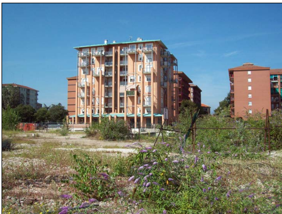
Figura 1.2/6 Comparto B UMI B4 – Edificio residenziale completato
