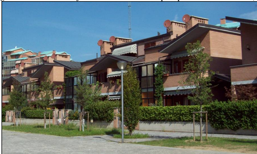
Figura 4.7.3/9: Gli edifici di Viale Piemonte prospicienti Via Trieste (R7)
