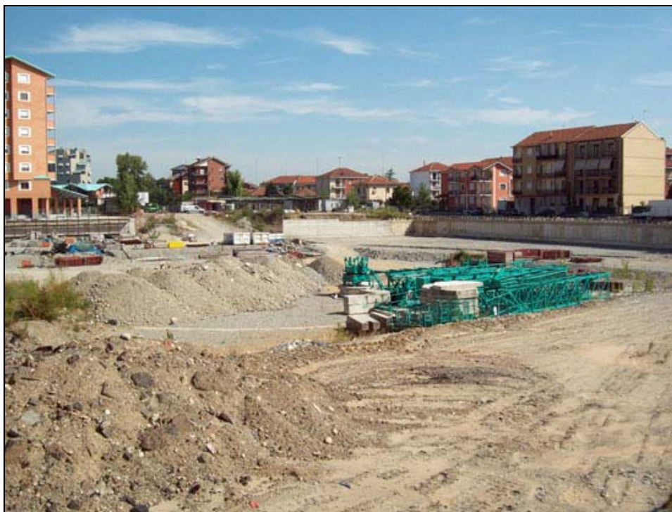
Figura 4.8/4: l'area di intervento vista da sud verso nord
