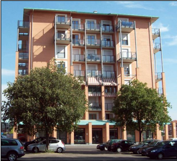
Figura 4.7.3/2: L'edificio residenziale pluripiano confinante a sud ovest con l'area di cantiere (R4)
