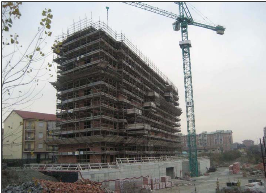
Figura 1.2/5 Comparto B UMI B3 – Edificio residenziale in corso di completamento
