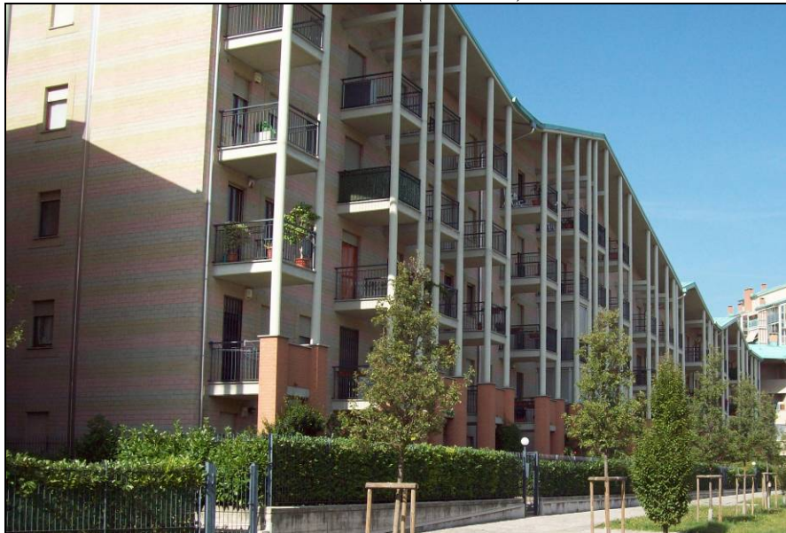
Figura 4.7.3/8: Gli edifici di Viale Piemonte prospicienti Via Trieste (R6)
