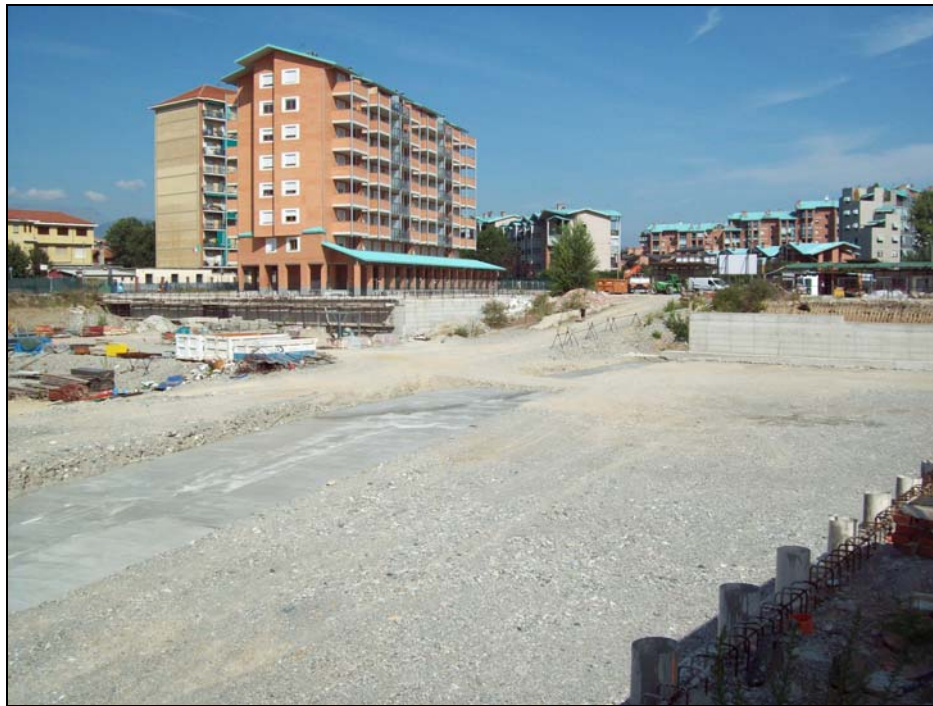
Figura 1.2/4 Comparto B UMI B1 – Edificio residenziale completato
