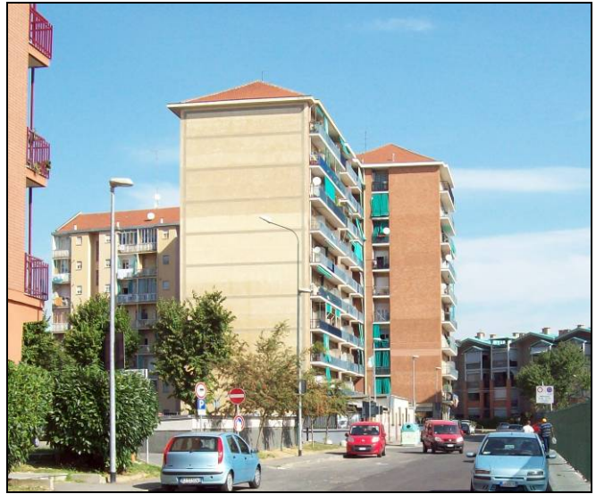
Figura 4.7.3/5: L'edificio residenziale pluripiano sito in Via Silvio Pellico angolo Via Trieste (R5)
